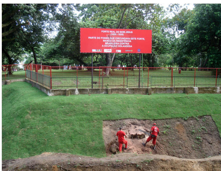
Figura 22 - Parte da contra-escarpa do fosso sendo revestida de grama esmeralda. Este tratamento deverá conter a erosão e permitir uma melhor visualização desta estrutura de defesa do Forte Real do Bom Jesus.
