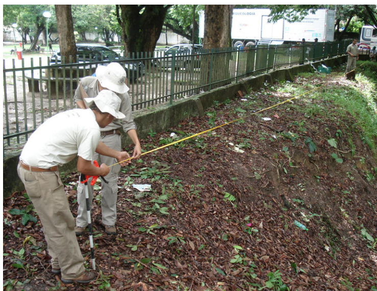
Figura 21 - Com a retirada da vegetação de grande porte inicia-se o processo de avaliação de danos, tanto da escarpa como da contra-escarpa. Como consequência desta avaliação foi retirada a camada de húmus produzido nos últimos 20 anos.
