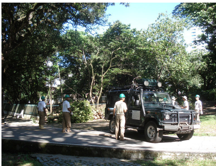
Figura 19 - Algumas árvores tiveram que ser amarradas no Land Rover com a finalidade de disciplinar a sua queda sem riscos para a estrutura da escarpa.
