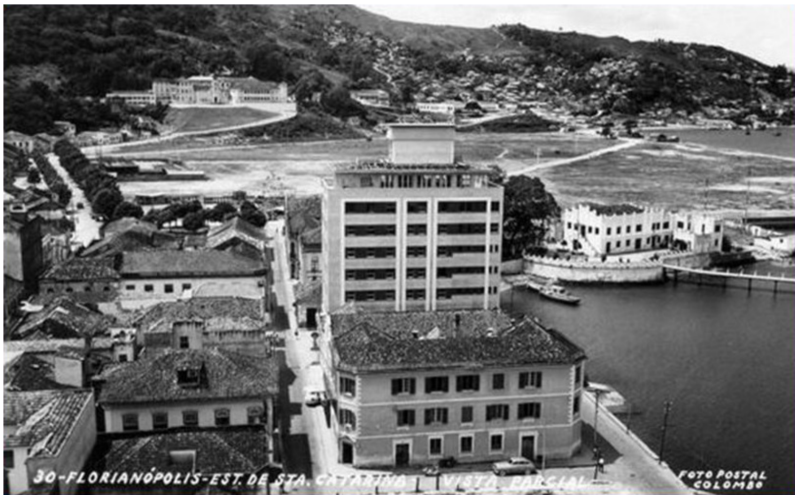
Forte de Santa Bárbara sendo isolado das águas da Baía Sul
